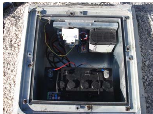
Slika 31. Postavljanje uređaja sistema u kutiju u betoniran otvor u podnožju stuba [12]
