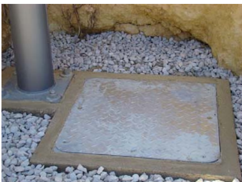
Slika 31. Postavljanje uređaja sistema u kutiju u betoniran otvor u podnožju stuba [12]
